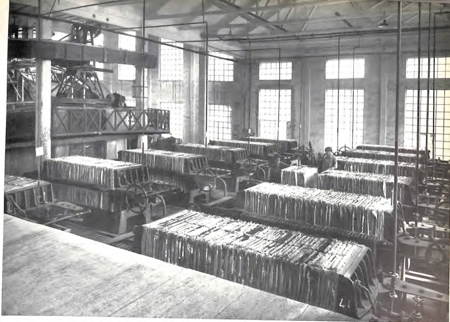
Monteponi - Impianto per lo zinco elettrolitico - Filtri pressa.
